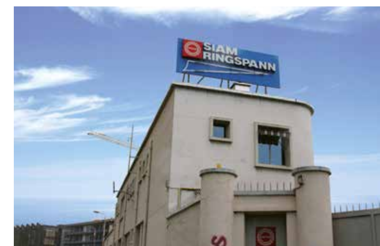
Bâtiment SiAM-RINGSPANN en destruction programmée
