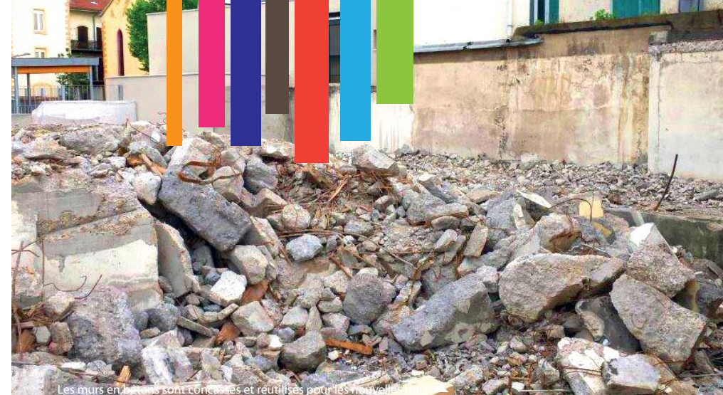
Les murs en béton sont concassés et réutilisés pour les nouvelles
