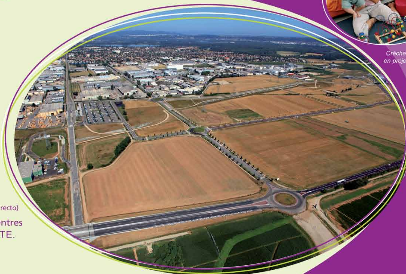
Vue aérienne sur les terrains du Parc industriel des Gaulnes En arrière plan, la zone industrielle existante Photo : 08/2010.
