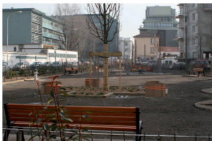
Le jardin des Abruzzes en travaux - Février 2011
